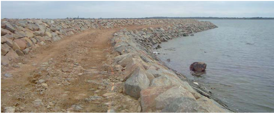
D'importants travaux de renforcement de digues sont réalisés sur la côte Est.
