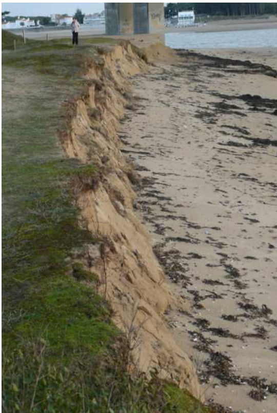
17-11-2010 : Erosion continue sous le pont au niveau de la première pile. Les falaises de sable de l'ancienne dune et celle reconstituée avec les restes du dépôt de sable prélevé sont toutes les deux attaquées !
