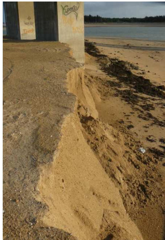
17-11-2010 : Erosion continue sous le pont au niveau de la première pile. Les falaises de sable de l'ancienne dune et celle reconstituée avec les restes du dépôt de sable prélevé sont toutes les deux attaquées !
