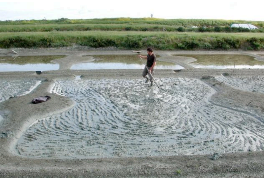
Répartition de l'argile sur toute la surface de l'œillet
