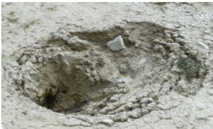
*Trou d'effondrement survenu au printemps 2009 dans l'estuaire de l'Etier de l'Arceau, au pied de la digue du Boucaud*
